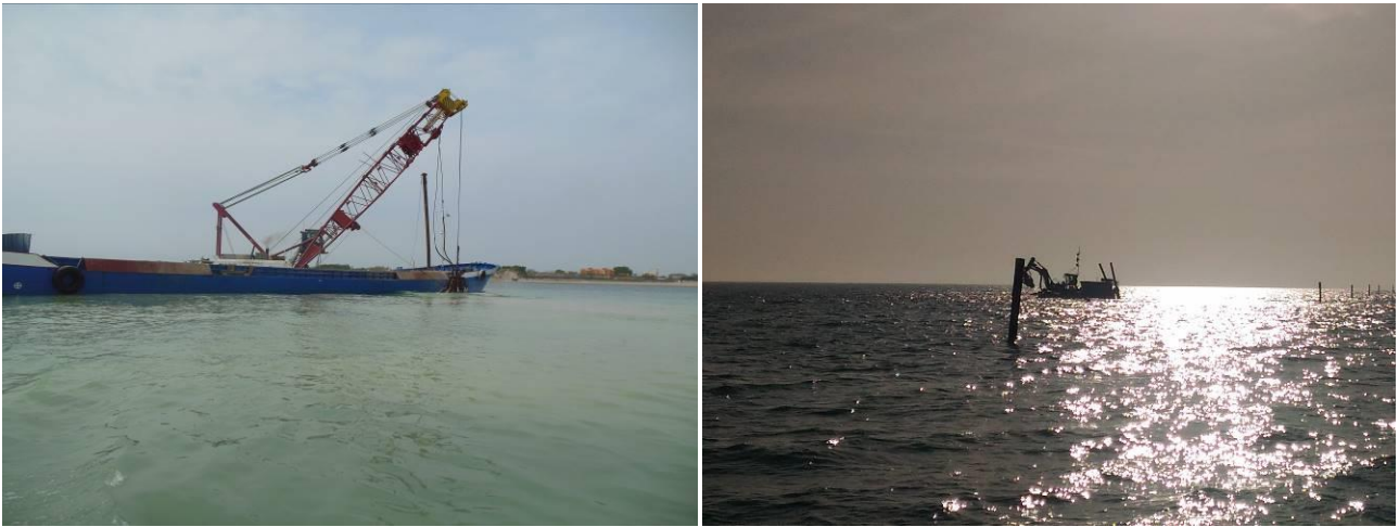
Esempi di attività di interventi infrastrutturali a mare
